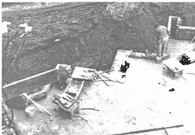
Prace przy budowie Wyższego Seminarium Duchownego
